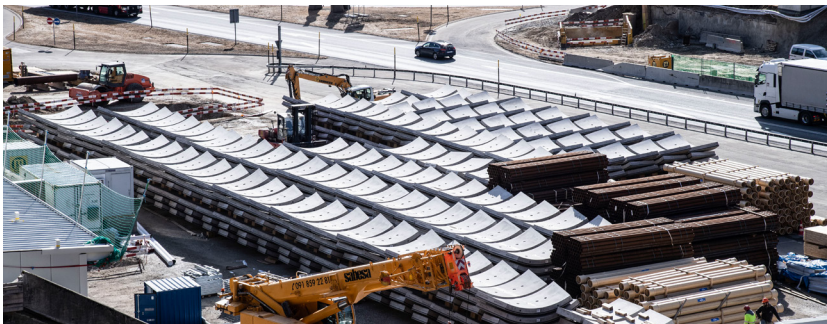
I conci prefabbricati vengono utilizzati per consolidare le pareti del cunicolo di accesso e sono temporaneamente depositati ad Airolo, proprio accanto all'autostrada.
