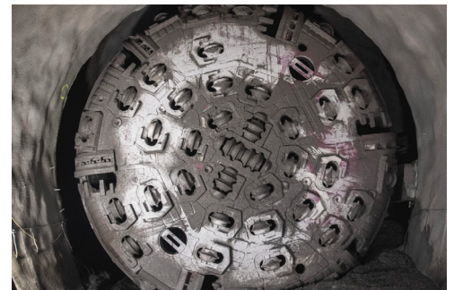
La testa della fresa meccanica all'interno del cunicolo di accesso sud.
