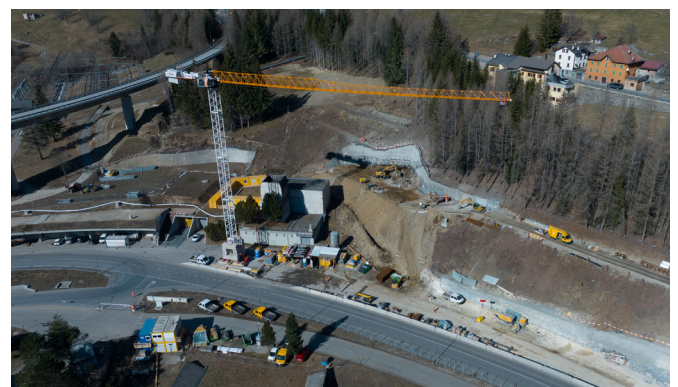
La trincea d'approccio per l'accesso della fresa meccanica nella galleria principale.
