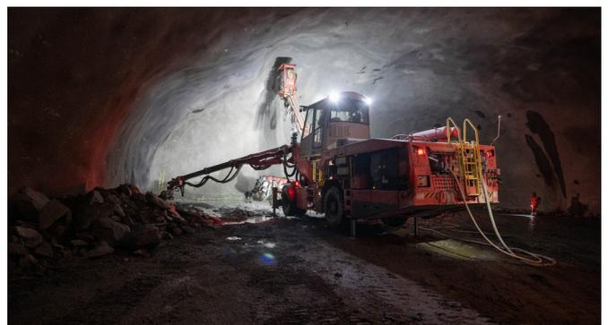
Die ersten rund 320 Meter werden im Gegenvortrieb von Süden nach Norden ausgebrochen. In diesem Bereich wird später die Tunnelbohrmaschine aufgebaut.
