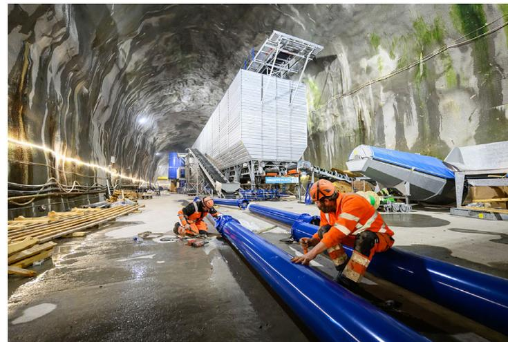
A causa dello spazio limitato nella Valle della Reuss, nel Canton Uri, a Göschenen è stata scavata una caverna di circa 40 000 m<sup>3</sup> nella quale si sta attualmente montando l'impianto sotterraneo di produzione di calcestruzzo.
