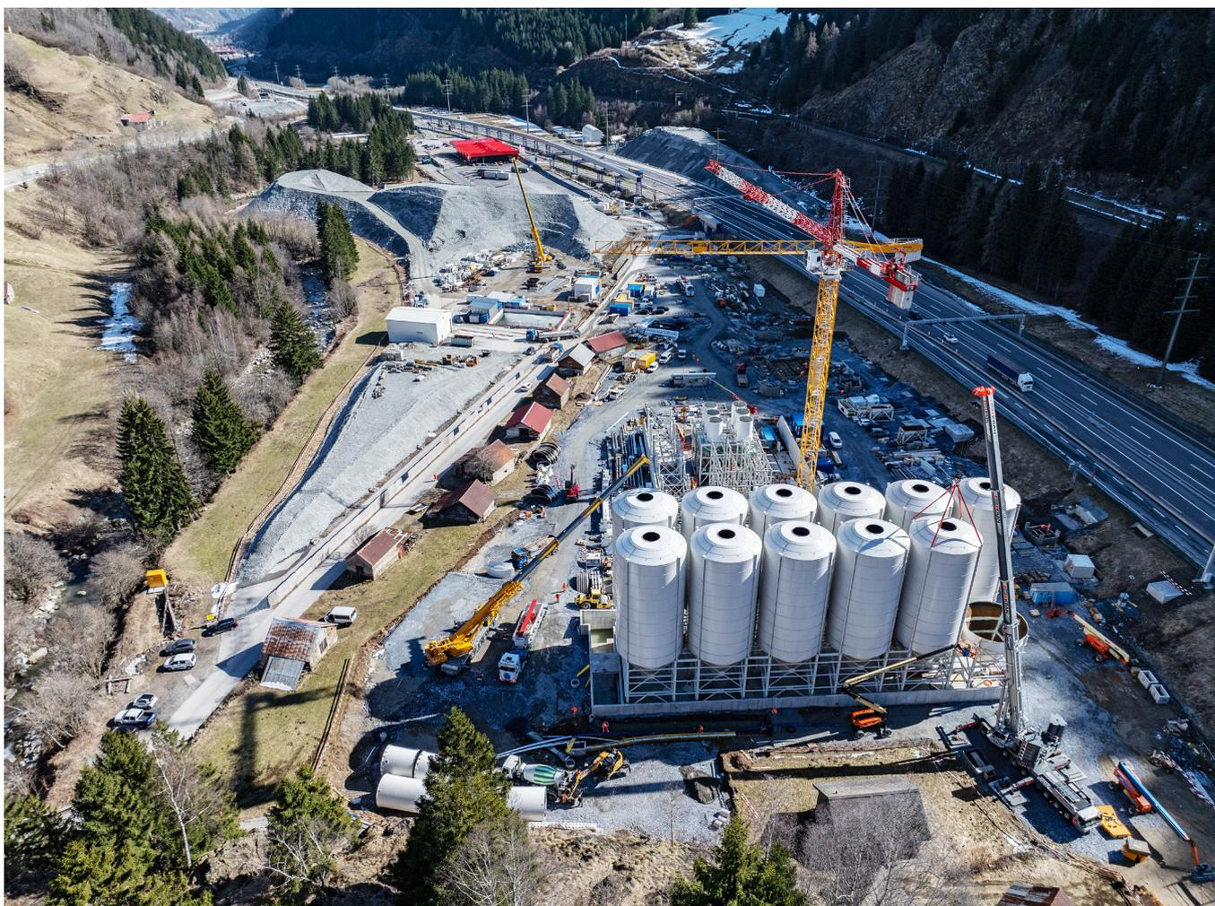
In der Materialaufbereitungsanlage bei Stalvedro wird das gesamte Ausbruchmaterial in zwei Kategorien sortiert und geeignetes Material zur Weiterverwendung aufbereitet. An Spitzentagen werden hier ab 2025 bis zu 15 000 Tonnen Material erwartet. Das Material wird auf Deponien sowie in den vor Kurzem installierten 12 Silos, mit je einem Fassungsvermögen von 1400 Tonnen Gestein, gelagert werden. Bis zum Ende dieses Jahres wird die Anlage fertiggestellt.
