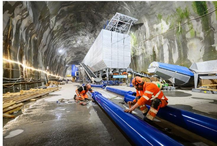
Aufgrund der engen Platzverhältnisse im Urner Reusstal wurde in Göschenen eine Kaverne mit einem Volumen von ca. 40 000 m<sup>3</sup> ausgebrochen. In dieser wird zurzeit die unterirdische Betonanlage montiert.
