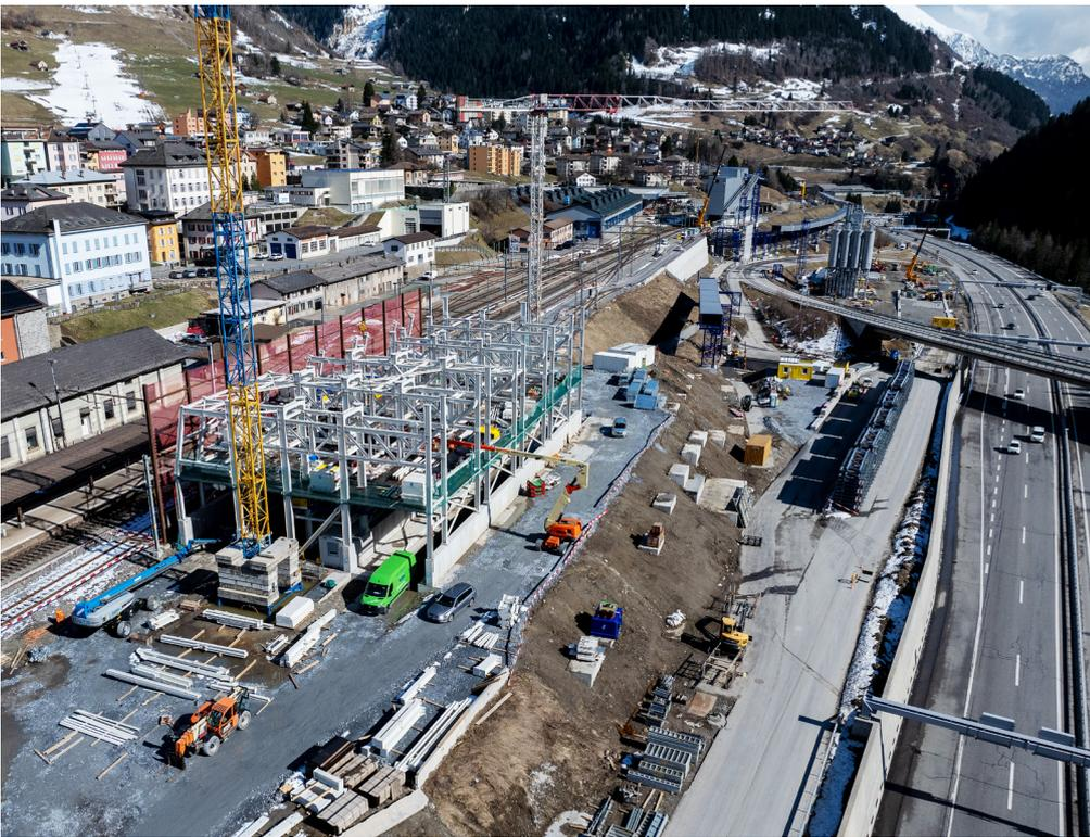
Der Materialtransport zwischen den beiden Baustellen im Norden und Süden erfolgt durch den alten Gotthard-Bahntunnel. Dazu werden an den Bahnhöfen Airolo und Göschenen zurzeit verschiedene Verlade- und Entladeanlagen gebaut. In Airolo werden weiter drei zusätzliche Gleise gebaut.
