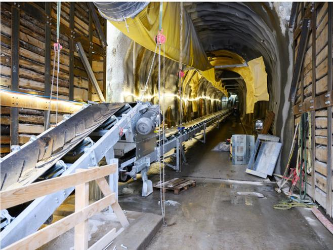
Für die Betonproduktion in Göschenen wird ab 2025 das dafür geeignete Material per Bahn aus Airolo angeliefert und über die Förderbandanlage zur Betonproduktionsanlage in den Berg geleitet.
