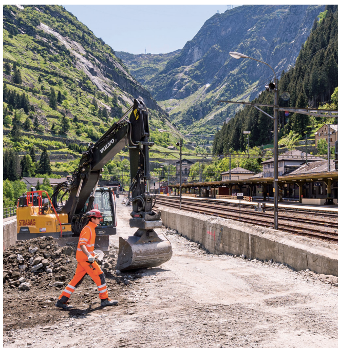
Erste Bauarbeiten beim Bahnhof Göschenen
