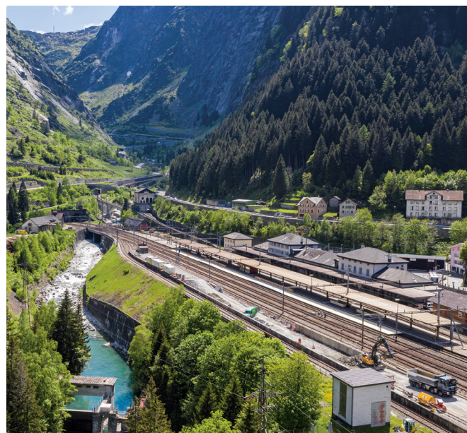
Blick auf die Bauarbeiten beim Bahnhof Göschenen
