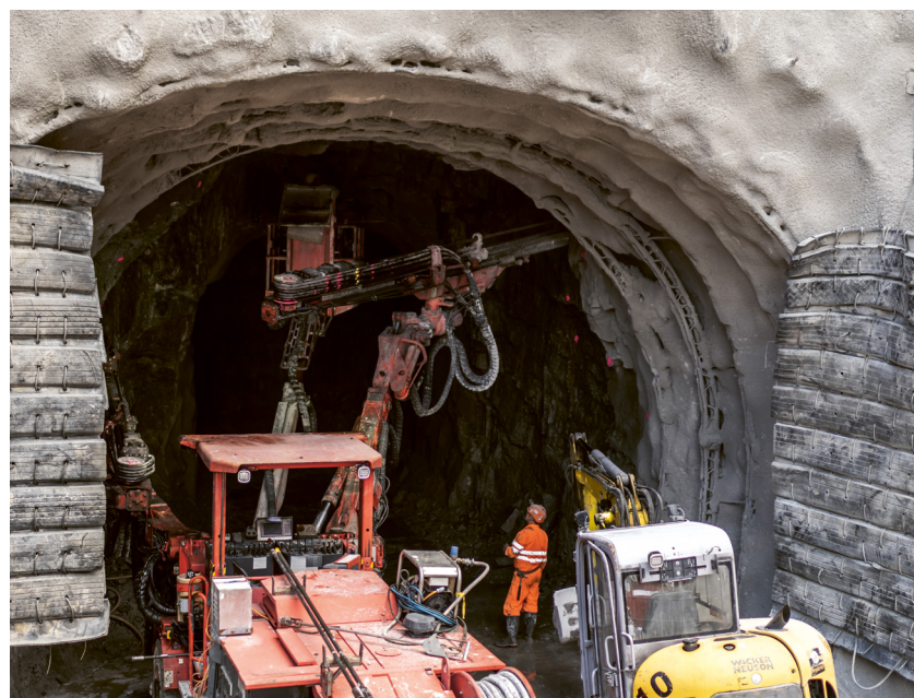
Con un perforatore si realizzano dei buchi che vengono poi caricati con l'esplosivo. Una volta riempiti i fori si fa detonare la carica.
