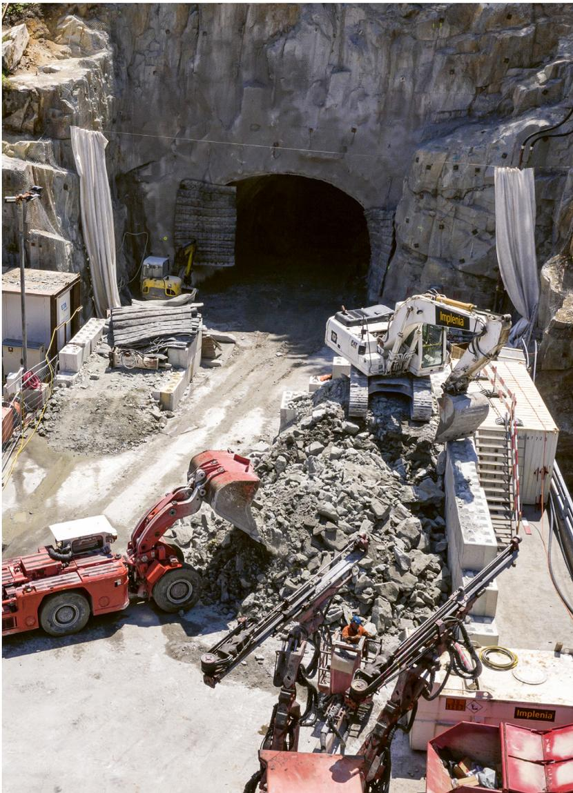
Der neue Eingang zum S1Sto entsteht auf dem Areal des Werkhofs in Göschenen. Beim Bau kommen Baumaschinen und Sprengstoff zum Einsatz.
