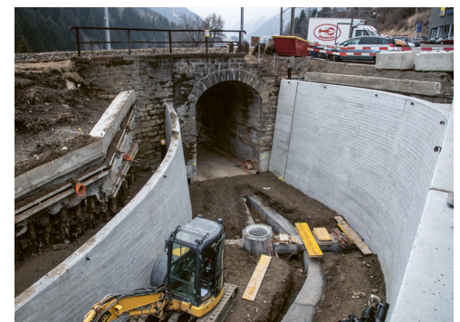
Abbassamento del sottopasso Foppe per permettere il transito dei mezzi di cantiere.
