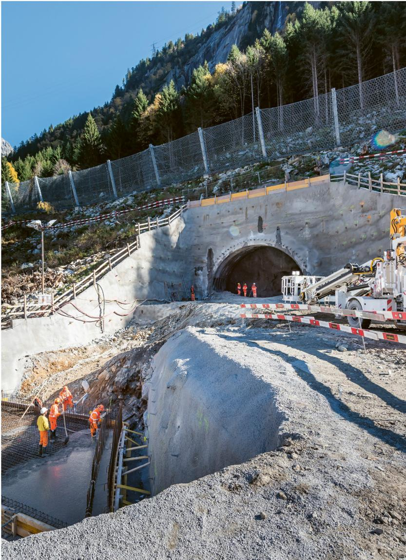
Auf dem Areal «Eidgenössisch» befindet sich der Eingang des 4,1 Kilometer langen Zugangsstollens zur Mesozoikum-Störzone. Ab Sommer 2022 wird hier die erste Tunnelbohrmaschine ihren Weg durch den Berg graben.
